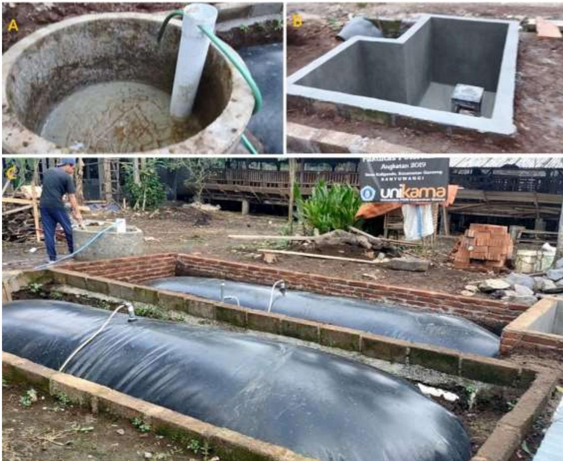
Gambar 5. Konstruksi biogas pada mitra: a) bak penampung slurry dan pipa masukan (*inlet*); b) bak saluran pengeluaran (*outlet*); c) digester balon paralel
