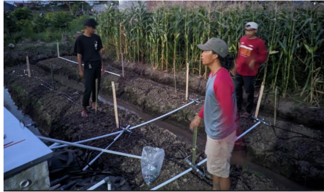
Gambar 4. Proses instalasi dan pengujian sistem IoT SMARTBULB.
