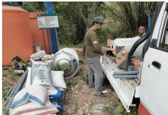
Gambar 5. Persiapan dan Pengenalan Alat Bahan di Lokasi Pemasangan Alat
