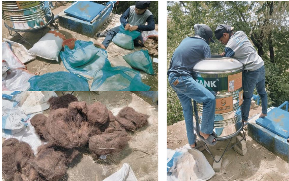
Gambar 6. Pengisian Bahan-Bahan Filtrasi Kedalam Tangki Filter Awal
