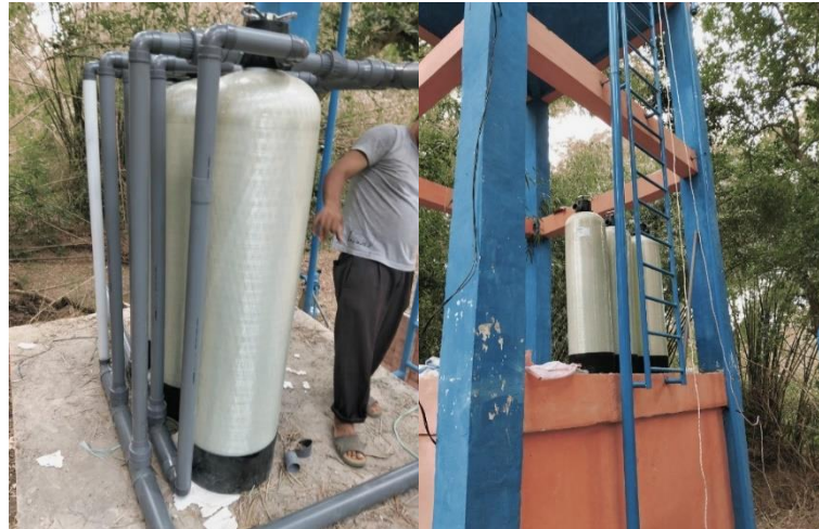
Gambar 7. Pemasangan Filter Bawah Menggunakan Filter Tabung FRP
