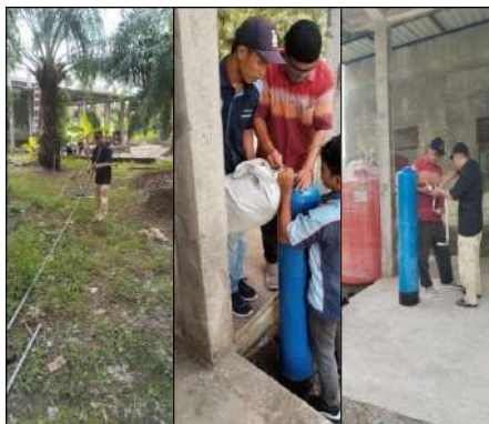
Gambar 8. Foto pemasangan perpipaan dan media filter (carbon, silica, mangan)
