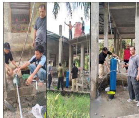
Gambar 9. Foto proses instalasi sampai keluar air bersih
