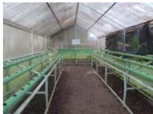
Gambar 3. Kondisi Greenhouse Setelah Dibersihkan
