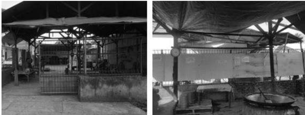
Gambar 2. Penggunaan triplek - terpal untuk menutupi bagian pinggir lokasi dan atap
