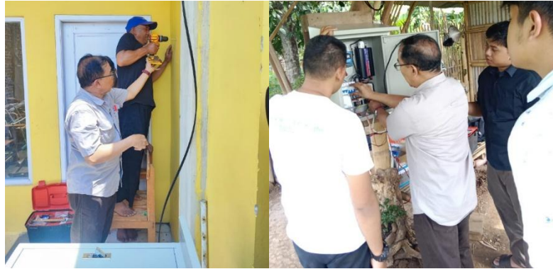
Gambar 2. Proses pemasangan Panel
