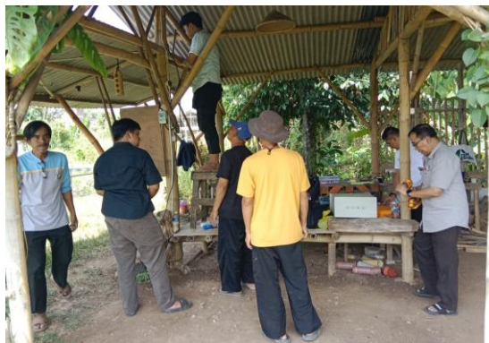
Gambar 3. Instalasi di Gazebo
