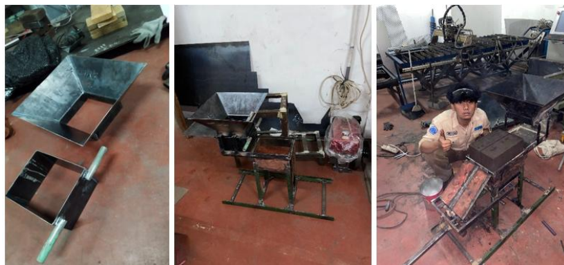
Gambar 2. Pembuatan Mesin Cetak Batako dan Uji Fungsi
