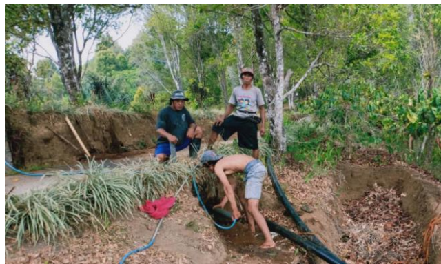
Gambar 3. Pengabdi bersama tim sedang instalasi pipa HDPE
