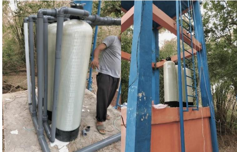
Gambar 7. Pemasangan Filter Bawah Menggunakan Filter Tabung FRP
