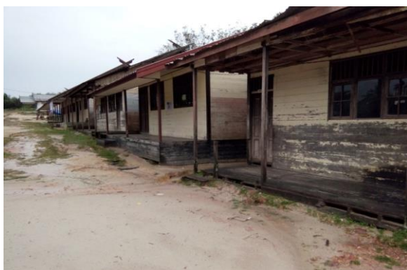
Gambar 1. Kondisi gedung sekolah
