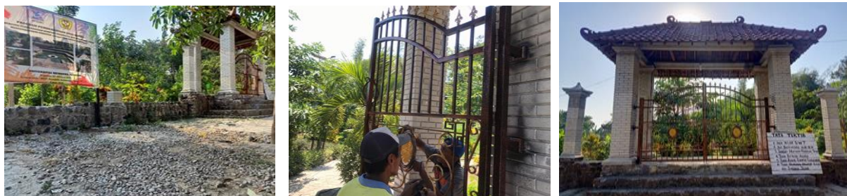
Gambar 6. Pemasangan Pintu Di Gapura Pintu Masuk Taman Dewi Sri
