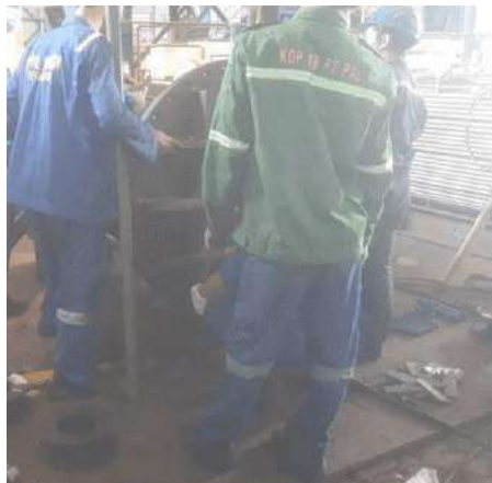
Gambar 2. Proses pemasangan tubesheet hydrotest
